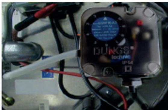
**Bei Inbetriebnahme der Gasbrenner Fabrikat Giersch, sind folgende Werte am Lufterdruckwächter LGW 10A2 einzustellen:**
